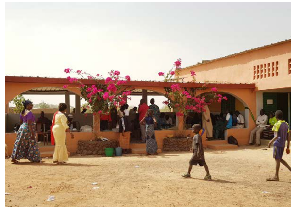
En del av den nya byggnaden är denna uteplats med tak där det sker vägning och mätning av barnen, undervisning, vaccinering med mera. Foton tillhör Birgitta Amoroso.
